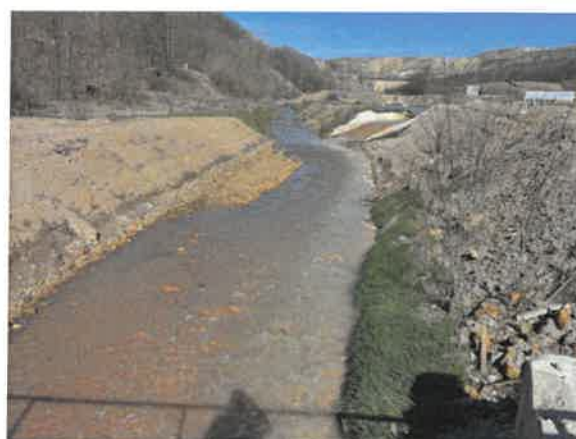
4. Борска река пре улива Кривевршке реке из тунела
