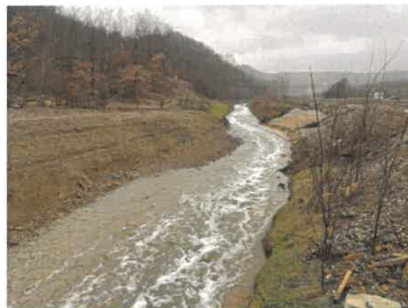
4. Борска река пре улива Кривељске реке из тунела
