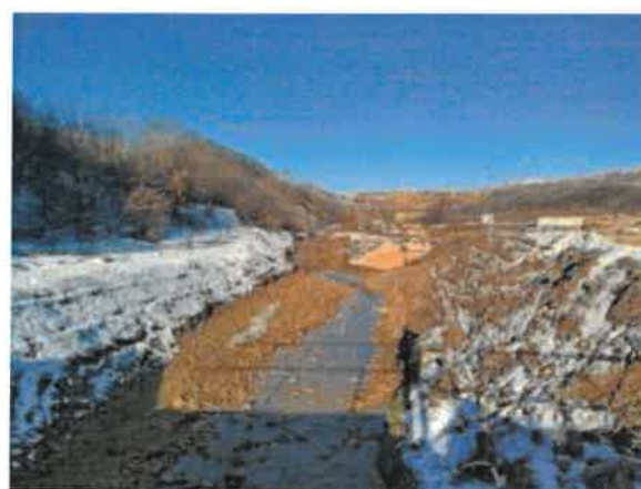
4. Борска река пре улива Кривељске реке из тунела
